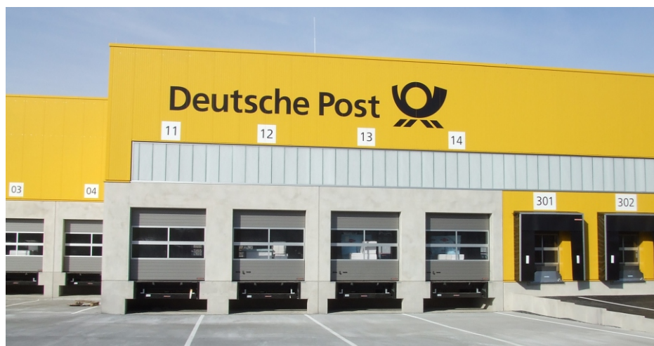
DHL MechZB Hamm - Uentrop
