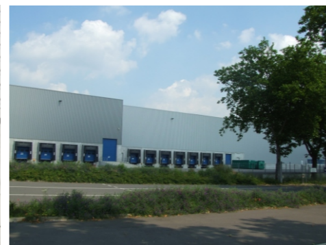
Ladebereich Hallen J, K
