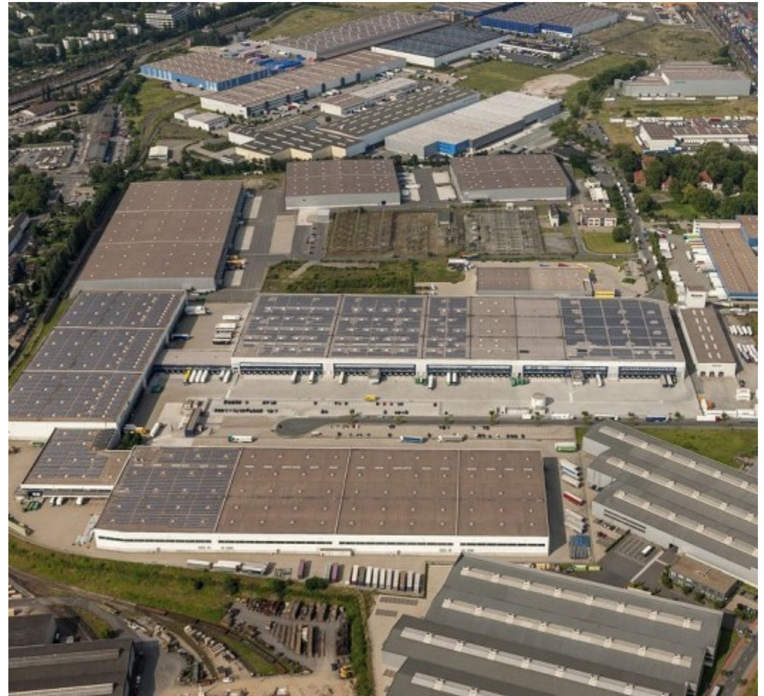
Luftaufnahmen nach Fertigstellung
