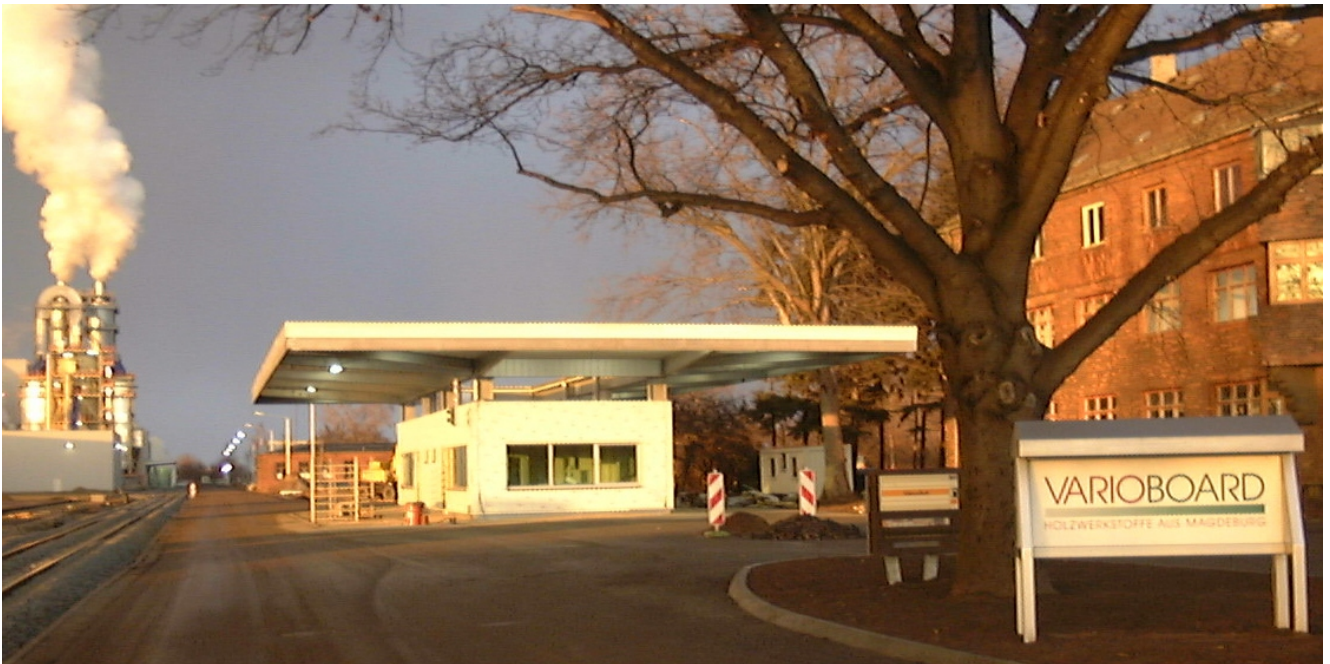
Pförtnergebäude, Einfahrt zum Varioboardgelände
