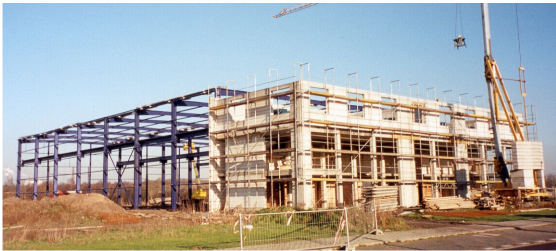
Während der Bauausführung
